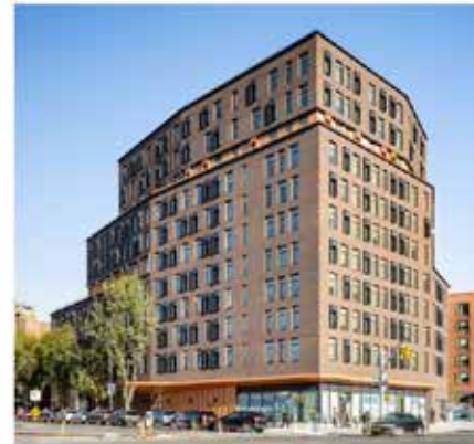
Tres Puentes 2550 3rd Ave. Bronx, NY
